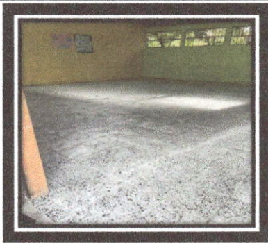
Colocación de piso de granito INEB Telesecundaria El Pato.
